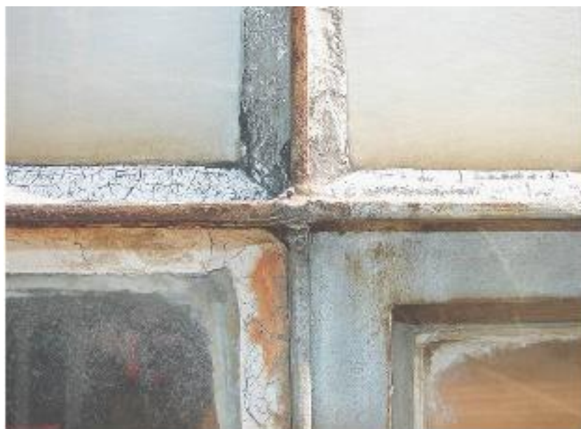
Stucco per finestre e stucco di riempimento (a base di olio di lino)
